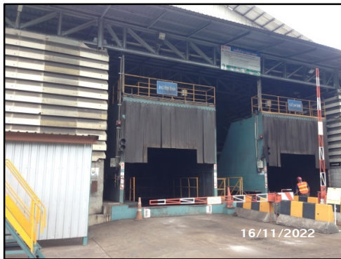
ภาพที่ 3.67 การทำ Hood คลุมอ่างเทเชื้อเพลิง
