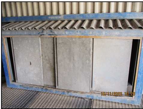
ภาพที่ 3.84 Casing ฝุ่นชุด Hammering Equipment ในหม้อไอน้ำ
